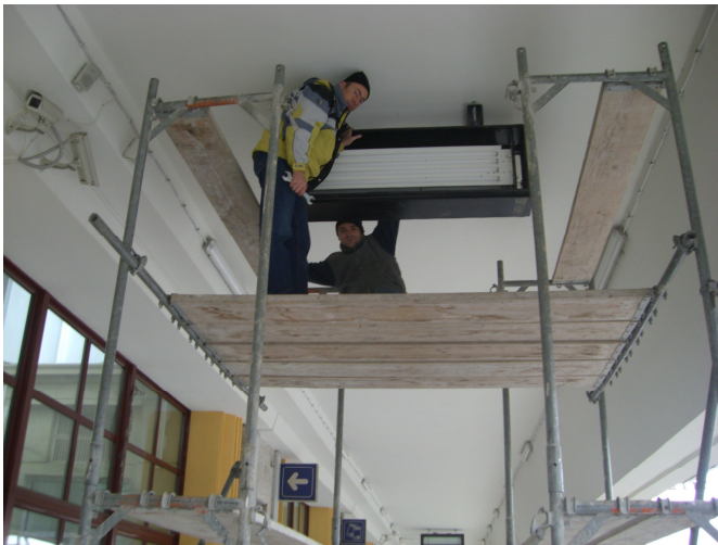
Instalare panou afisare mersul trenurilor peron
