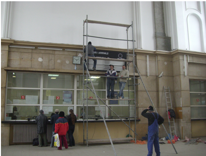
Instalare panou afisare mersul trenurilor hol central
